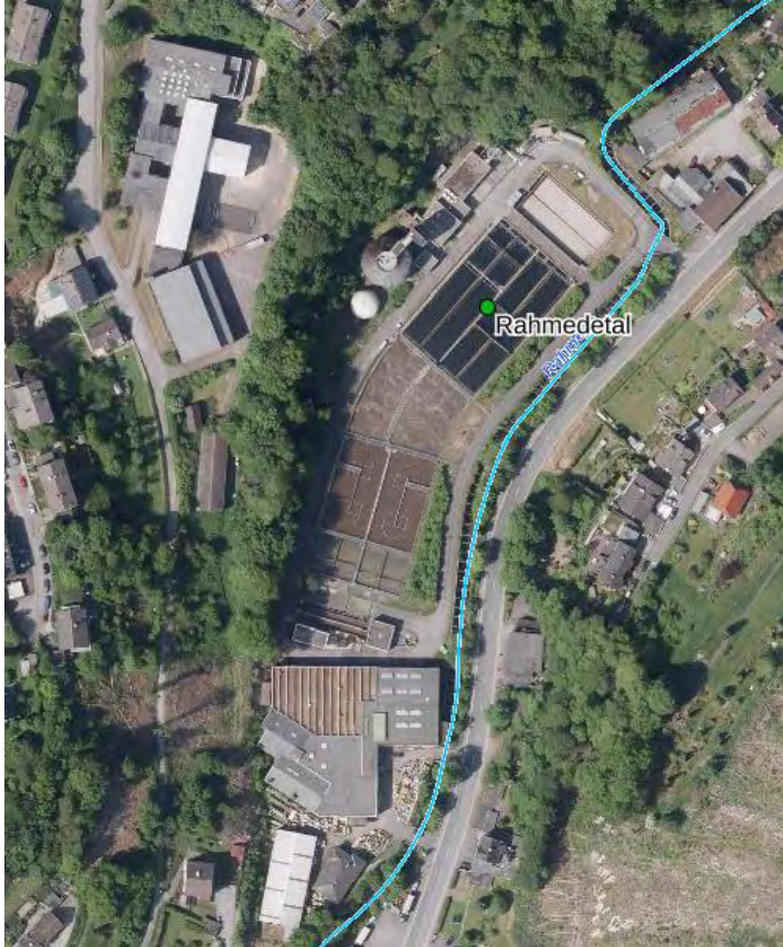
Abb. 14: Luftbild Kläranlage Rahmedetal ( www.elwasweb.nrw.de , Abruf 24.05.2024)
