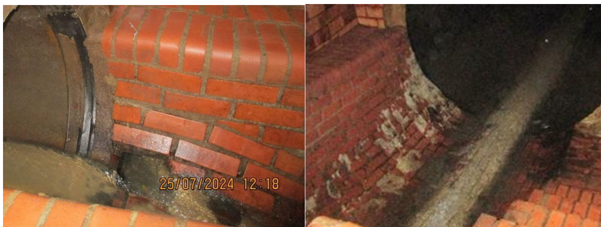
Abbildung 5: SKU Dahle Fuhleck Einlaufbauwerk Schadensbilder (ausgewählte Fotos)
