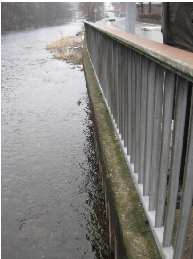
Abb. 27: Spundwandverbau im Bereich der geplanten Einleitung des RÜ Marktstraße
