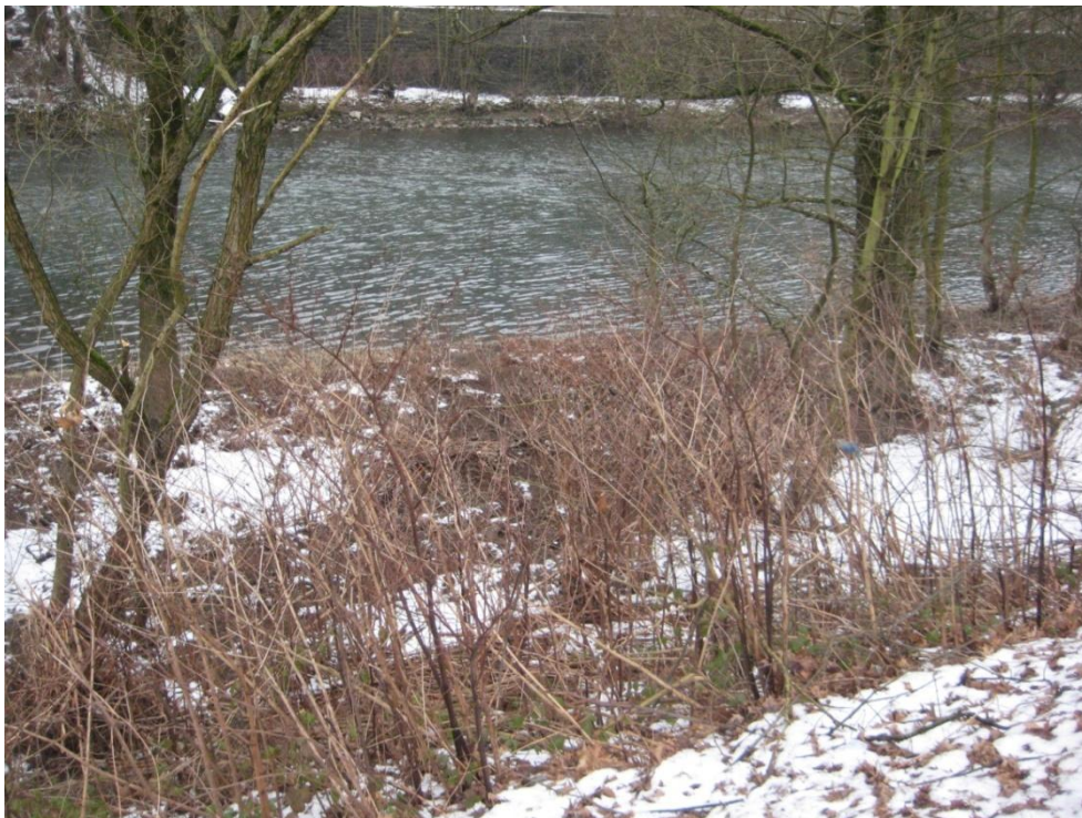
Abb. 32: Lenne- Uferböschung im Bereich der geplanten Einleitung RÜ Linscheidstraße
