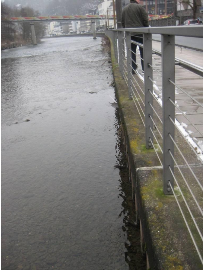
Abb. 28: Spundwandverbau im Bereich der geplanten Einleitung des RÜ Im Küstersort
