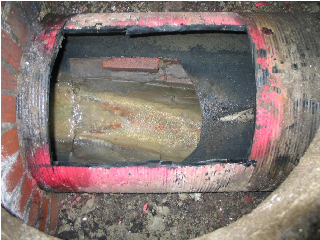
Abb. 8: Blick in den Regenüberlauf Südstraße
