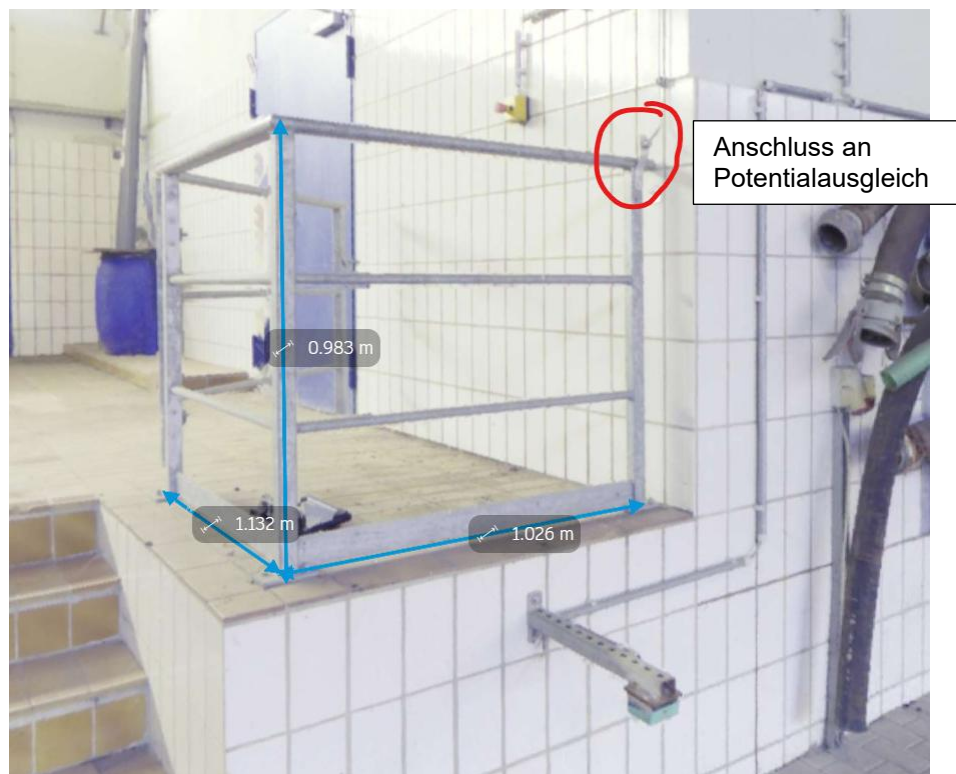
Schutzgeländer mit Klapptür (Ansicht 1)
