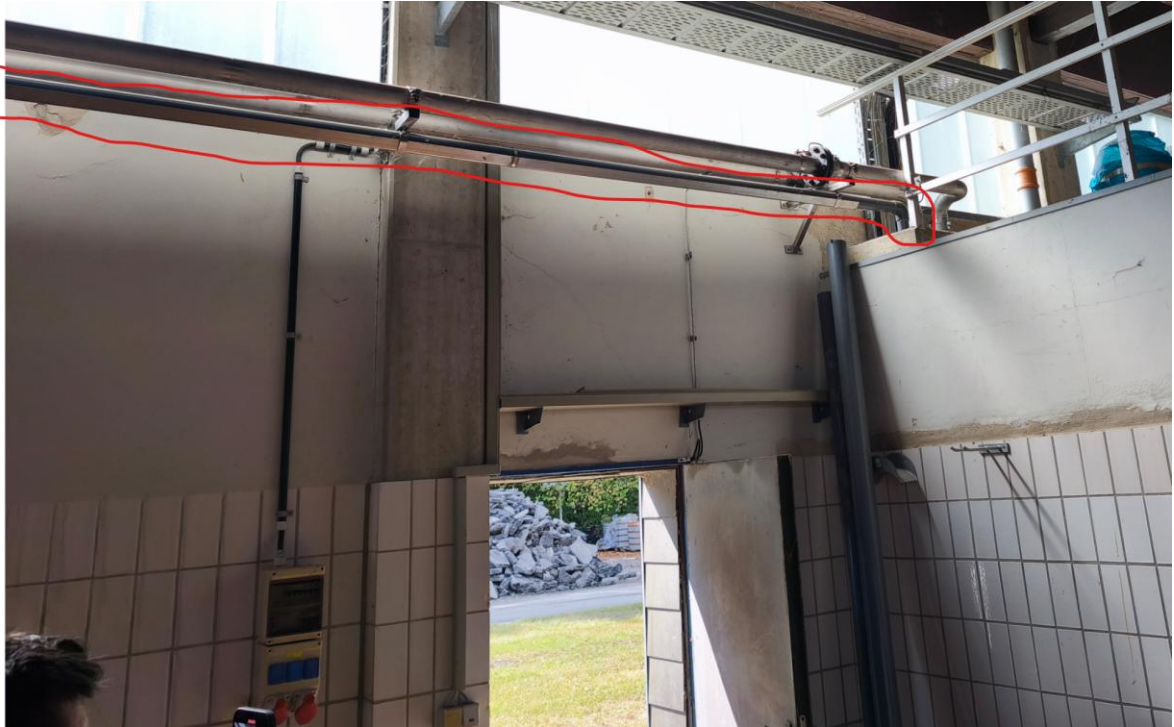
Vorh. Brauchwasserleitung aus PVC
