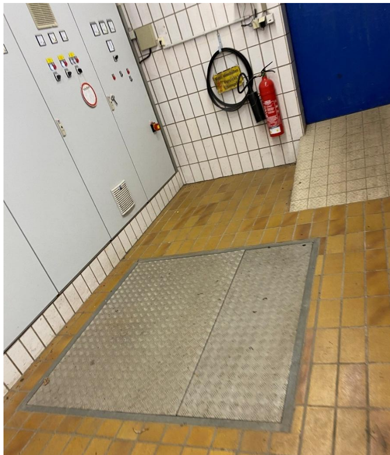
Montageöffnung Pumpenkeller
