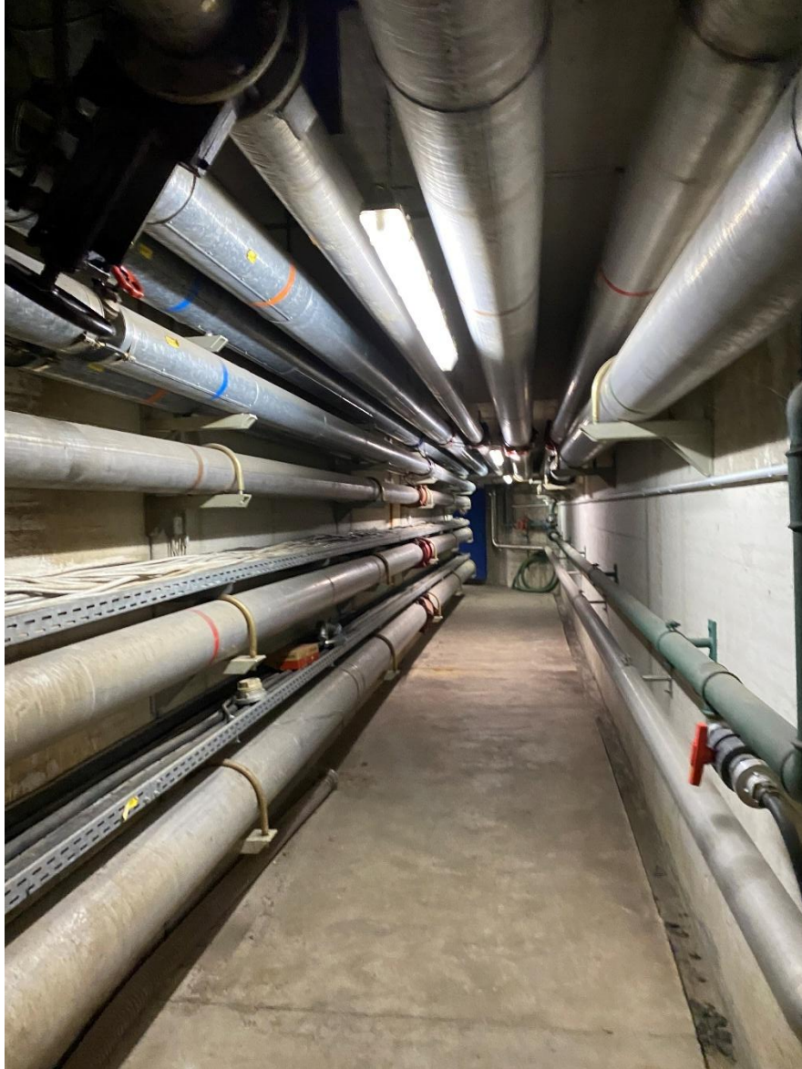
Rohrkanal zum Pumpenraum
