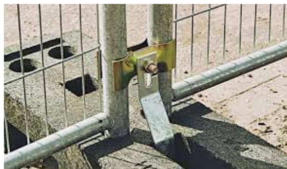
Bild: Beispiel für eine Aushebesicherung für den Bauzaun
