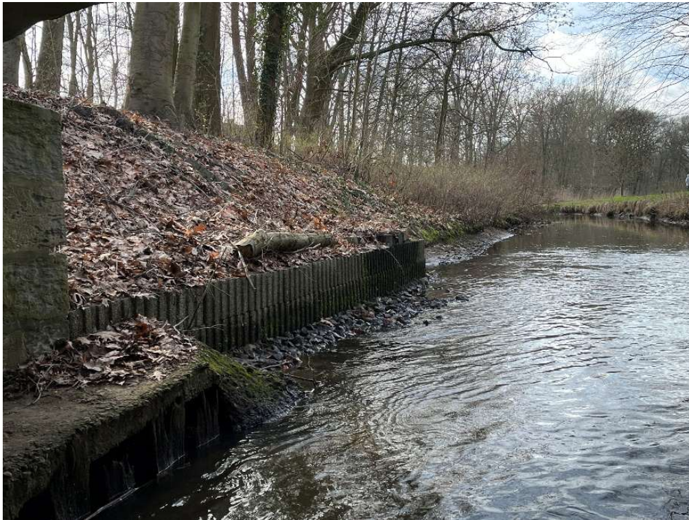
Abbildung 21: Ansicht Böschungsbefestigung Süd/West
