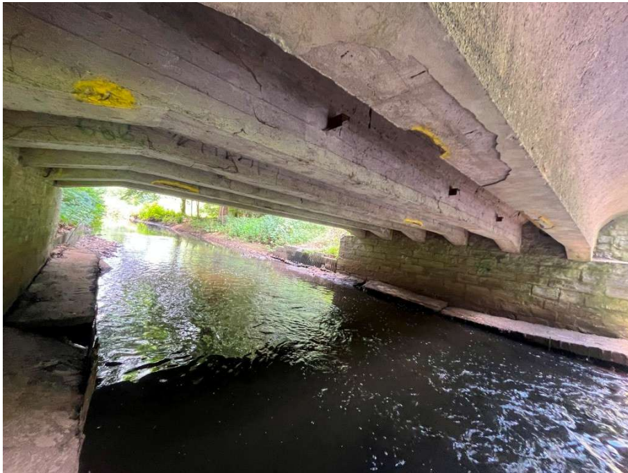
Abbildung 3: Untersicht Überbau mit Abplatzungen
