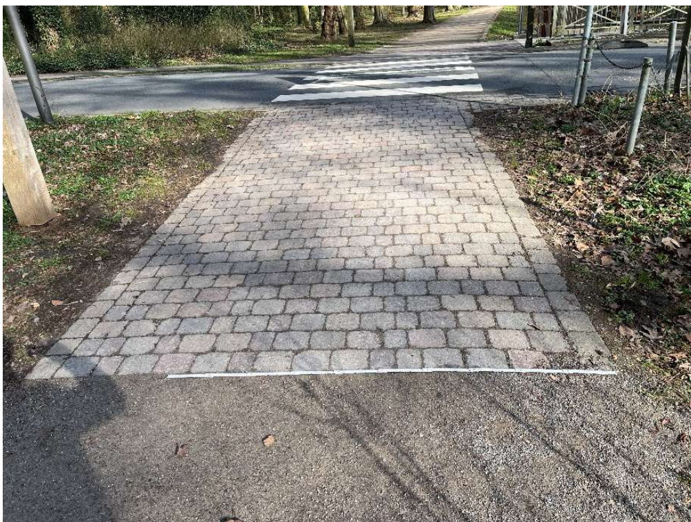
Abbildung 24: Natursteinpflaster Nord/West ausbauen, zwischenlagern, wiederherstellen
