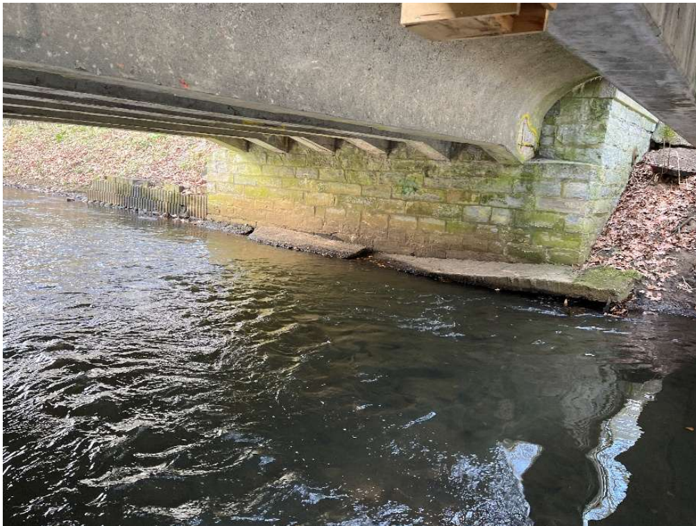
Abbildung 18: Böschungssicherung vor Widerlagerwand Nord
