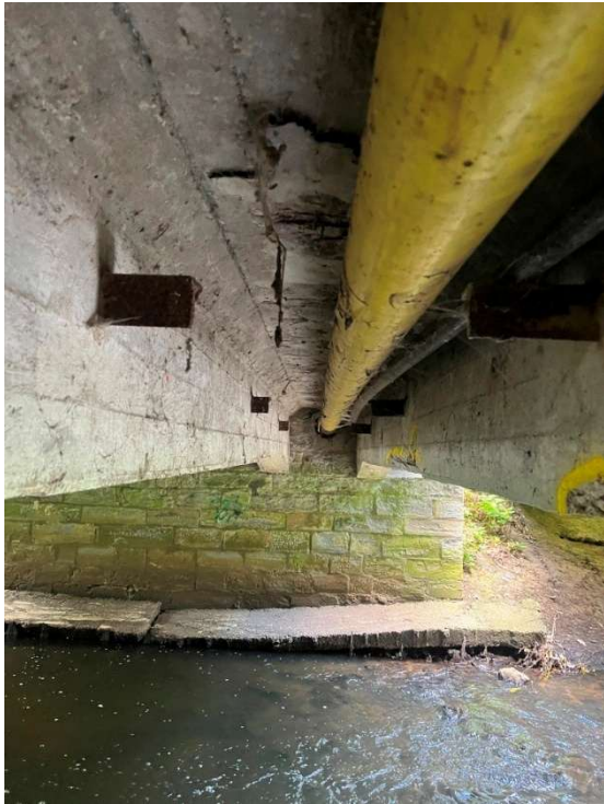
Abbildung 11: Untersicht Bestandsbauwerk mit Versorgungsleitungen
