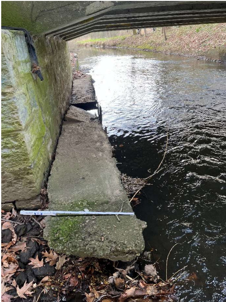
Abbildung 17: Böschungssicherung vor Widerlagerwand Süd
