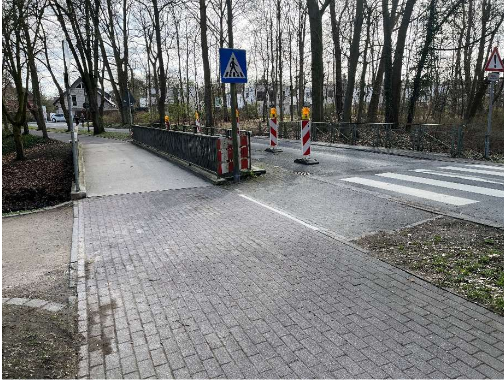
Abbildung 27: Betonsteinpflaster Nord/Ost Übergang ausbauen, zwischenlagern, wiederherstellen
