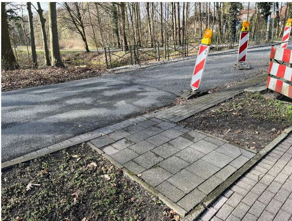
Abbildung 26: Gehwegplatten Süd/Ost ausbauen, zwischenlagern, wiederherstellen
