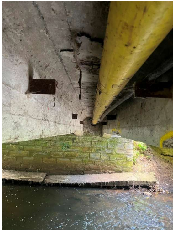
Abbildung 30: Untersicht Bestandsbauwerk mit Versorgungsleitungen
